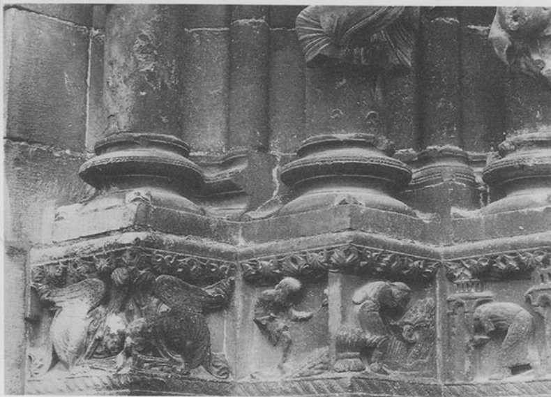
11. Bases des colonnes des statues de l'ébrasement gauche du portail central de la façade occidentale.
