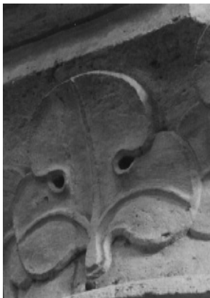
Arceuil nave aisle
