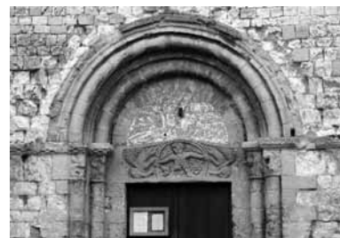
Rémérangles north door
